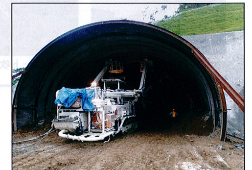
鋼製支保建込状況
