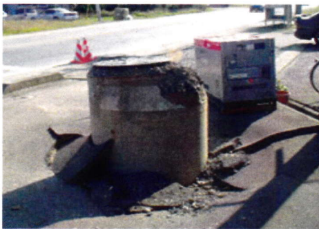
地震時における地盤の液状化現象によるマンホールの被害例（新潟県中越地震より）
