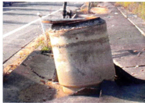
地震時における地盤の液状化現象によるマンホールの被害例（新潟県中越地震より）
