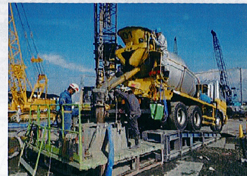
▲⑧コンクリート打設
