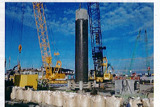
▲⑨スタンドパイプ引抜き
