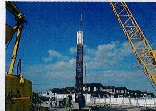
▲⑤鉄筋かご立て込み
