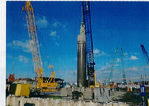
▲①スタンドパイプ打ち込み
