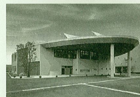
戸室リサイクルプラザ
