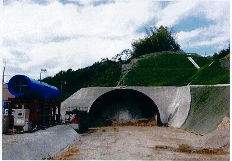
終点坑口部現況
